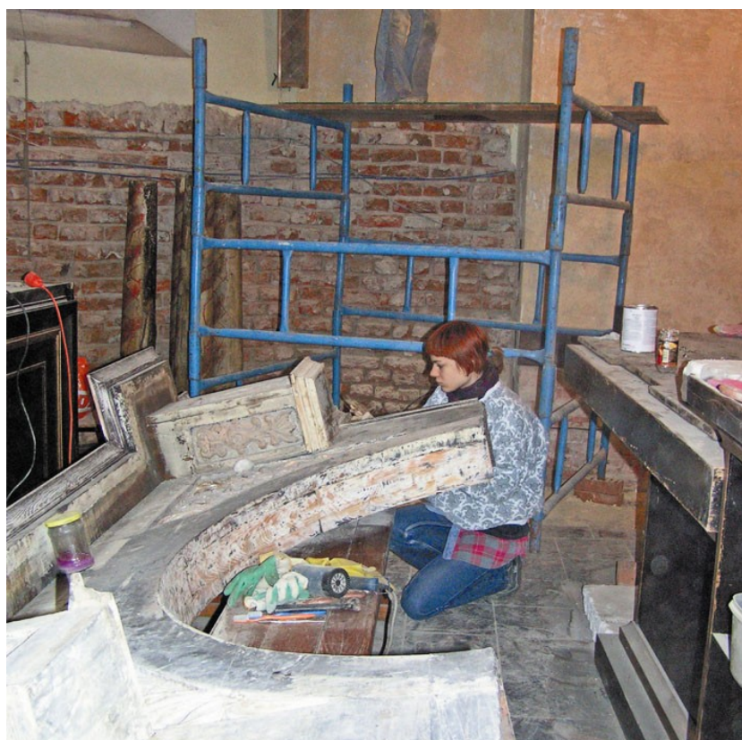
Przygotowywanie gzymsu ołtarza pod złocenie
