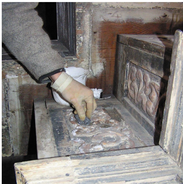
Zakładanie kitów wyrównujących zaprawę pod złocenie, na gzymsie ołtarzowym.
