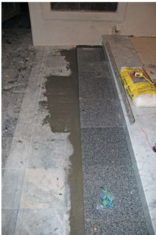
W trakcie kładzenia posadzki granitowej w kaplicy
